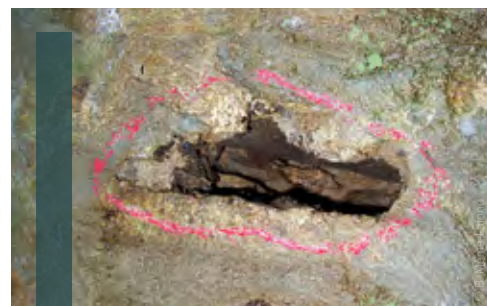
Marquage des disjointements pour maintien
