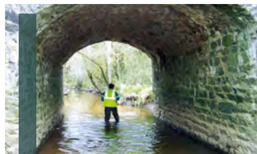
Expertise d'un pont
